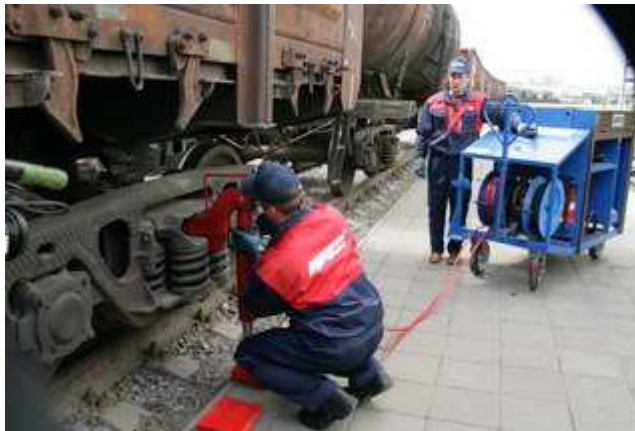
Передвигая комплекс вдоль железнодорожного состава, рабочие могут оперативно проводить ремонт
